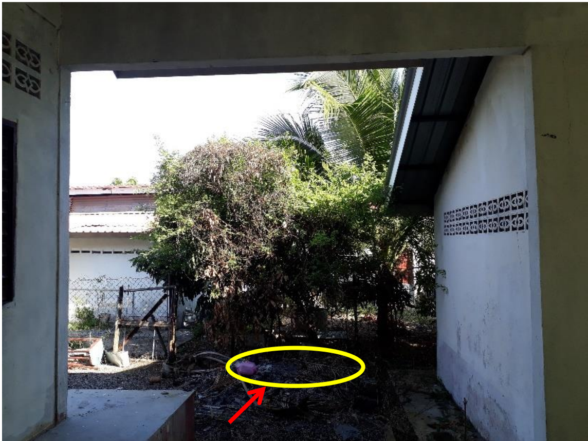
PEMBINAAN "SEPTIC TANK"
