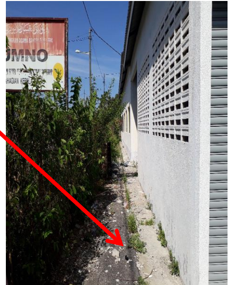
PEMBINAAN DAN PEMBAIKAN LONGKANG KELILING DEWAN
